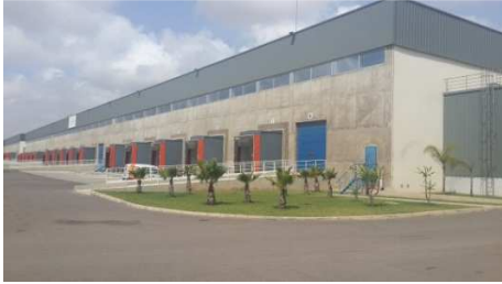
Figure 12: Centre logistique de la SNTL à Zenata (Tranche 1)
