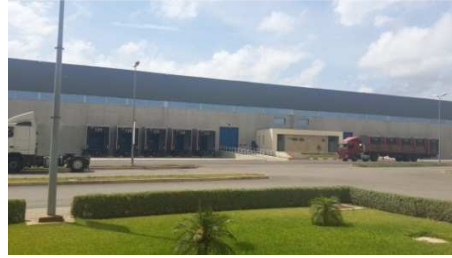
Figure13 : Centre logistique de la SNTL à Zenata (Tranche 2)
